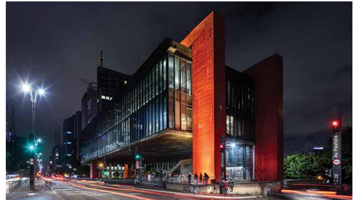
O projeto propõe ainda a substituição dos elementos de fixação dos vidros, permitindo a troca daqueles quebrados no lado externo da edificação e sanando problemas recorrentes de infiltração pela fachada.
